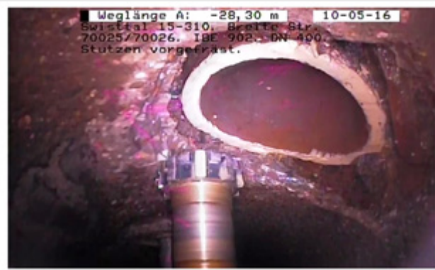
Bild 2: Dokumentation nach den Vorarbeiten
